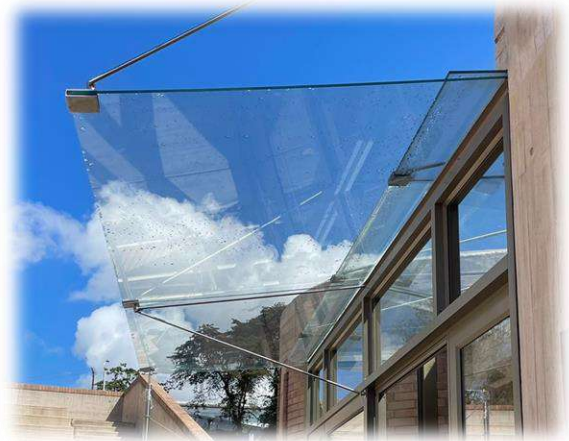
Ilustración 28 Cubierta complementaria del CCU
