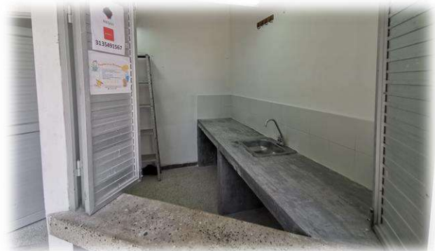
Ilustración 30 Adecuación de locales del campus Bicentenario
